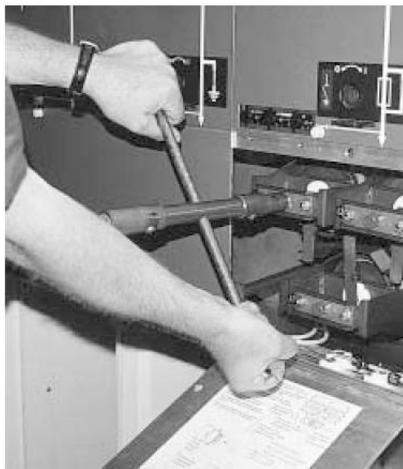
5. Приложив приводную рукоятку и, повернув её против часовой стрелки, открываем контейнеры для предохранителей
